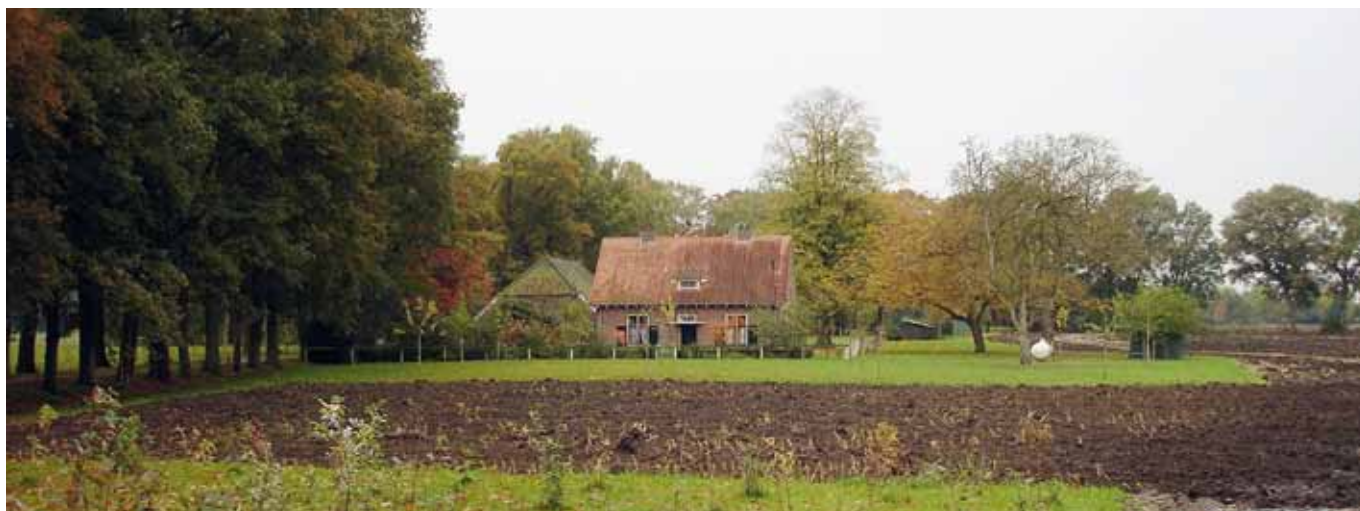
Erve Heuvelsland gezien vanaf de Elsmans Schaddenweg (oostzijde)
